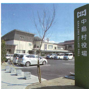
完成した役場外構工事
