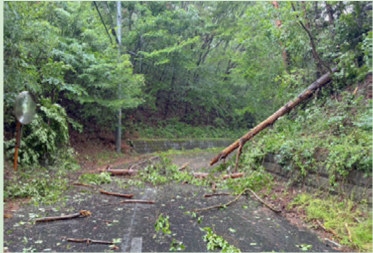
▲倒木した樹木破片が路上に散乱した状況
