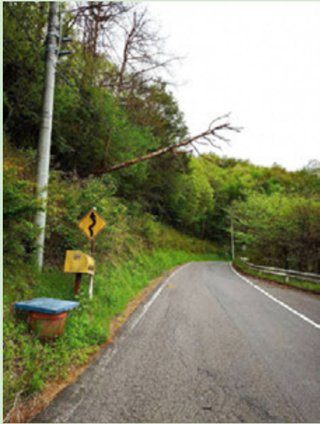
◀枯木が強風により倒れ道路上の電線にかかる状況
