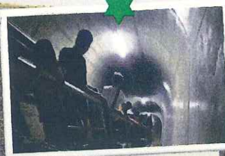
ダムトンネル内見学
