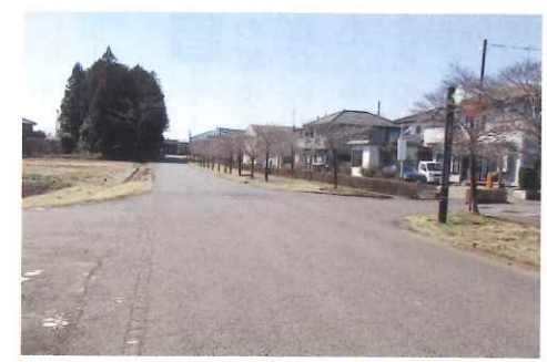
浦原ニュータウン前の区画線の様子
