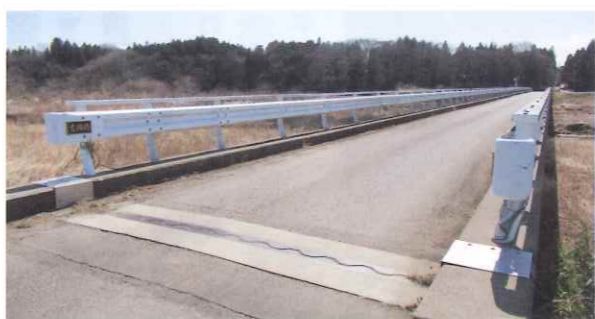
補修した吉岡橋
