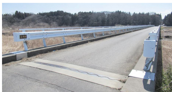
補修した吉岡橋
