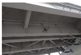
ドローンによる桁下の点検
