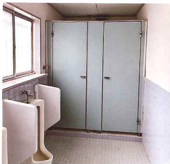
▶改修予定の吉子川小体育館トイレ
