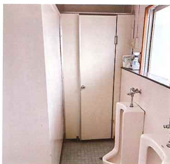
▶改修予定の滑津小体育館トイレ
