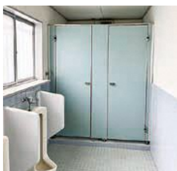
▶改修予定の吉子川小体育館トイレ
