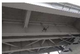
ドローンによる桁下の点検
