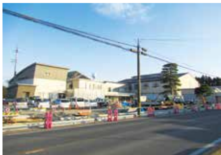
工事が進む役場整備事業外構工事
