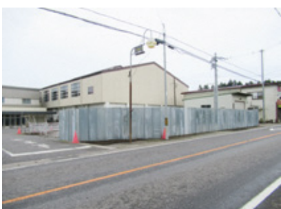
役場整備事業外構工事の様子
